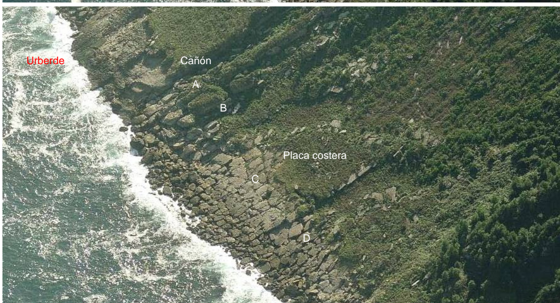
Figura 02. Plano del área de estudio y vistas desde el NW, con los sistemas de cuevas A-D. Fuente: b5m.
